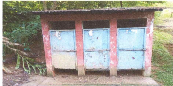
Foto 4: Cambio de puertas en los baños.
