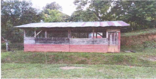
Foto 1: Cambio de entechado.
